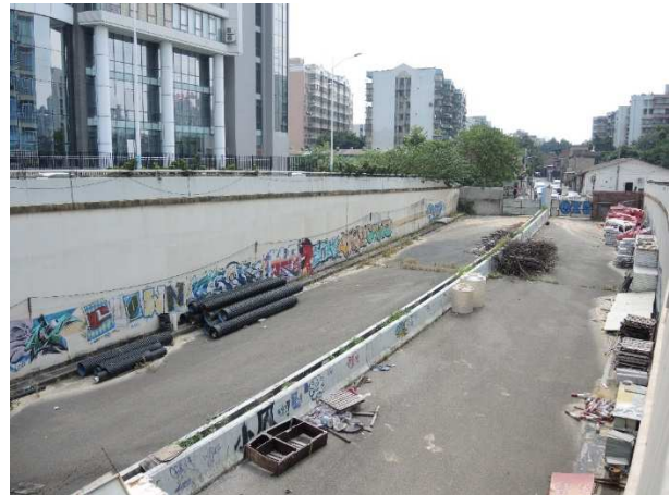
写真11 工事の止まった道路建設現場
