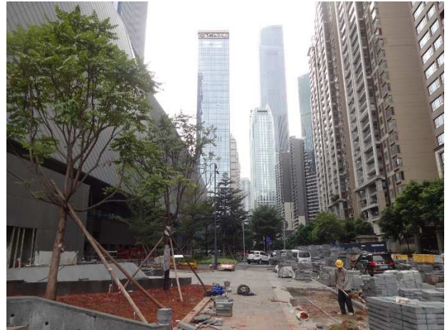
写真2 西部地区のオフィス街の建設
