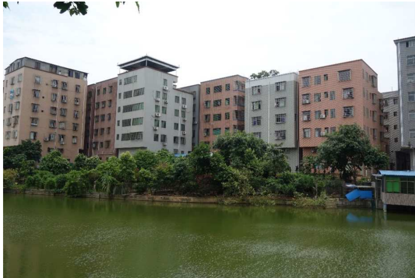
写真3 坑頭村の新しい集落の景観
